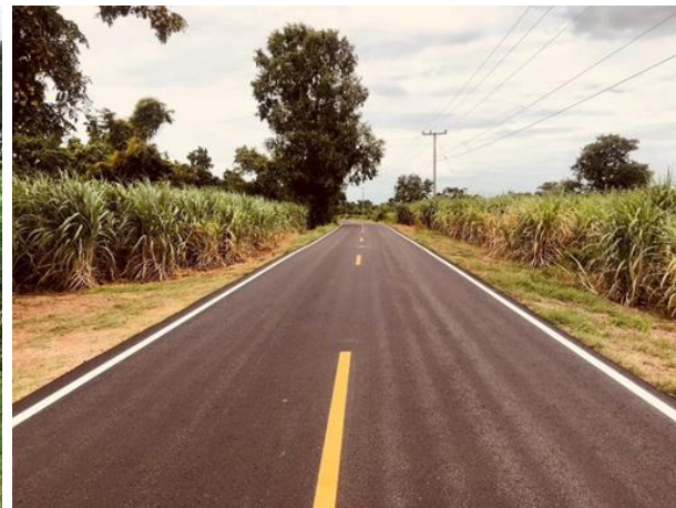
16.โครงการปรับปรุงถนน คสล.โดยปูยางแอสฟัลต์ติกคอนกรีตทับ คสล. เดิม รหัสทางหลวงท้องถิ่น นม.ถ.131 - 08 สายบ้านม่วง - บ้านช่อระกา บ้านช่อระกา หมู่ที่ 1
