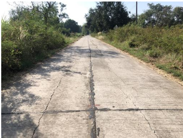
16.โครงการปรับปรุงถนน คสล.โดยปูยางแอสฟัลต์ติกคอนกรีตทับ คสล. เดิม รหัสทางหลวงท้องถิ่น นม.ถ.131 - 08 สายบ้านม่วง - บ้านช่อระกา บ้านช่อระกา หมู่ที่ 1
