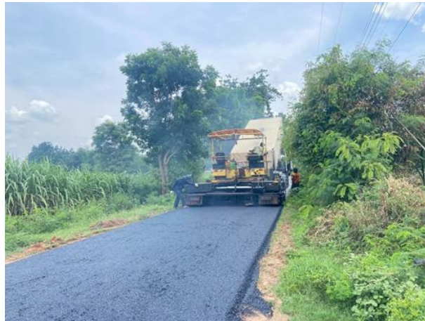
17.โครงการปรับปรุงผิวถนนคสล. โดยปูยางแอสฟัลต์ทับถนนคสล. เดิม รหัสทางหลวงท้องถิ่น นม.ถ. 131-03 ช่อระกา-โนนเพ็ด หมู่ที่ 7
