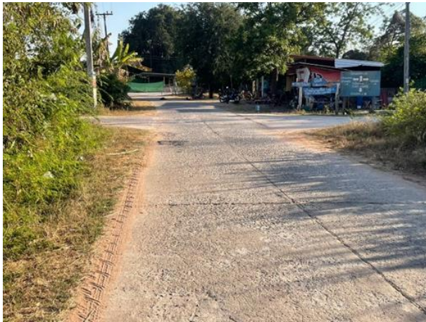
17.โครงการปรับปรุงผิวถนนคสล. โดยปูยางแอสฟัลต์ทับถนนคสล. เดิม รหัสทางหลวงท้องถิ่น นม.ถ. 131-03 ช่อระกา-โนนเพ็ด หมู่ที่ 7
