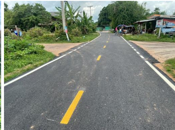
17.โครงการปรับปรุงผิวถนนคสล. โดยปูยางแอสฟัลต์ทับถนนคสล. เดิม รหัสทางหลวงท้องถิ่น นม.ถ. 131-03 ช่อระกา-โนนเพ็ด หมู่ที่ 7
