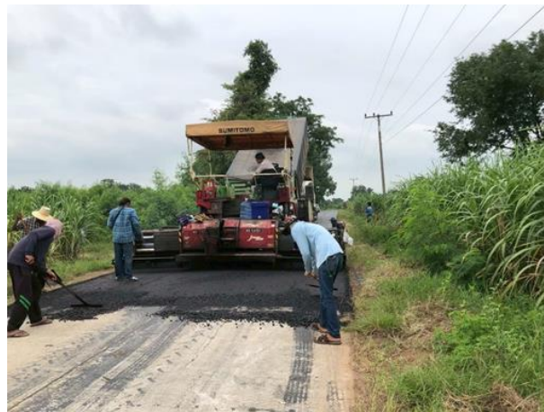
16.โครงการปรับปรุงถนน คสล.โดยปูยางแอสฟัลต์ติกคอนกรีตทับ คสล. เดิม รหัสทางหลวงท้องถิ่น นม.ถ.131 - 08 สายบ้านม่วง - บ้านช่อระกา บ้านช่อระกา หมู่ที่ 1
