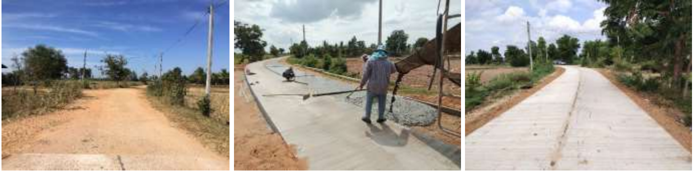
31. โครงการก่อสร้างถนน คสล.สายบ้านนายฉลองถึงถนนลาดยาง บ้านช่อระกา หมู่ที่ 1
