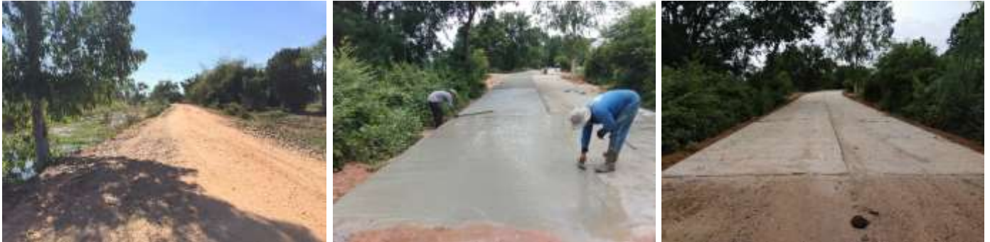
32. โครงการก่อสร้างถนน คสล.สายนางสนุ่นถึง แยกทางไปบ้านม่วง บ้านช่อบุรพา หมู่ที่ 7
